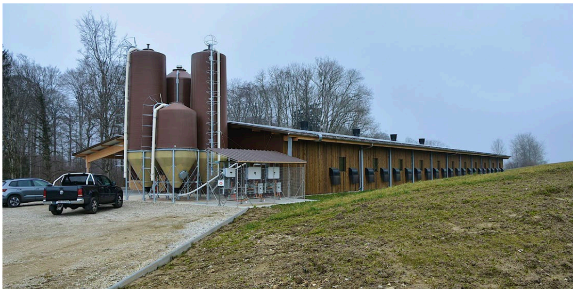
Le poulailler est recouvert de panneaux solaires.
